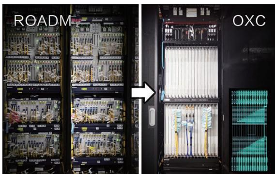
В аппаратной комнате одна единица оборудования OXC (справа) может заменить 9 традиционных шкафов ROADM + ODF (слева), что значительно экономит место и сокращает энергопотребление. Полностью оптические объединительные панели устраняют необходимость в выполнении оптоволоконных соединений вручную.
